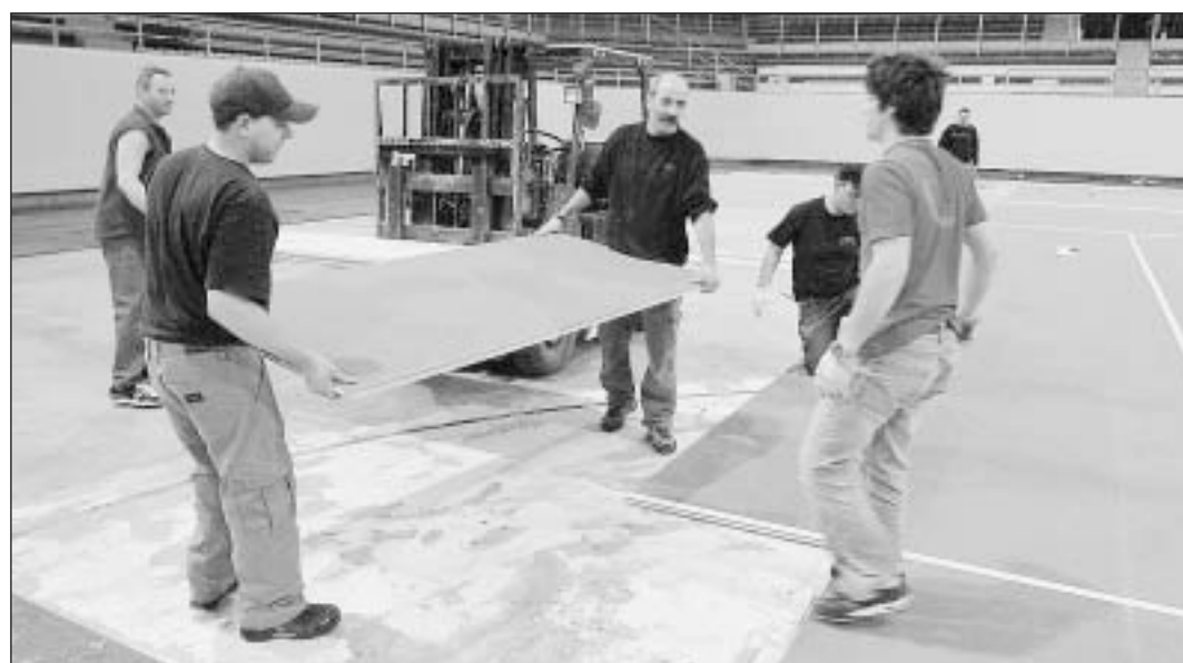
Gros travaux: 600 plaques posées pour 1000 m2 de surface.
